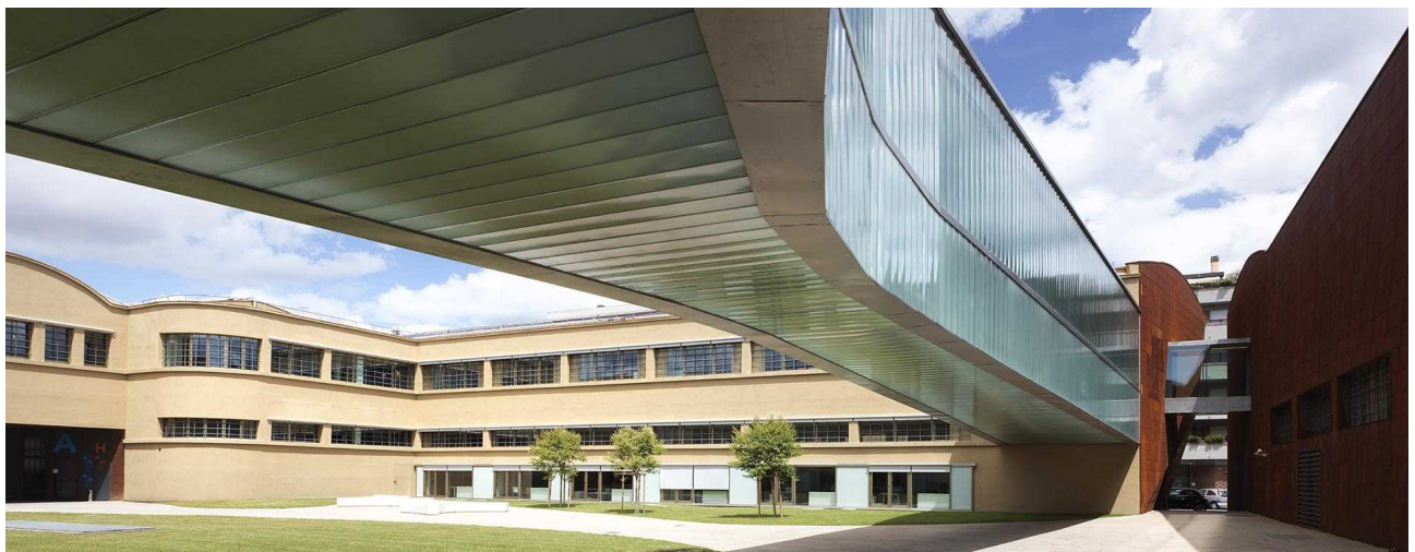
Illustrazione 2: il 'ponte' centrale
